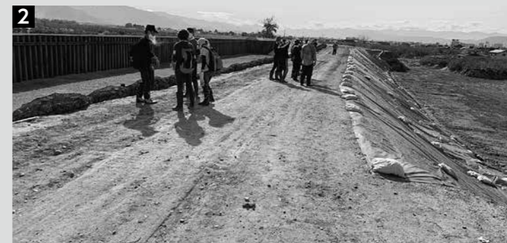
①津野サテライトの外観。②堤防決壊現場。修復が進み、鉄板で補強された仮堤防も設置されています。③・④日常生活が一変。自然の脅威を思い知らされます。⑤何度も何度も往復して、泥を運び出しました。
